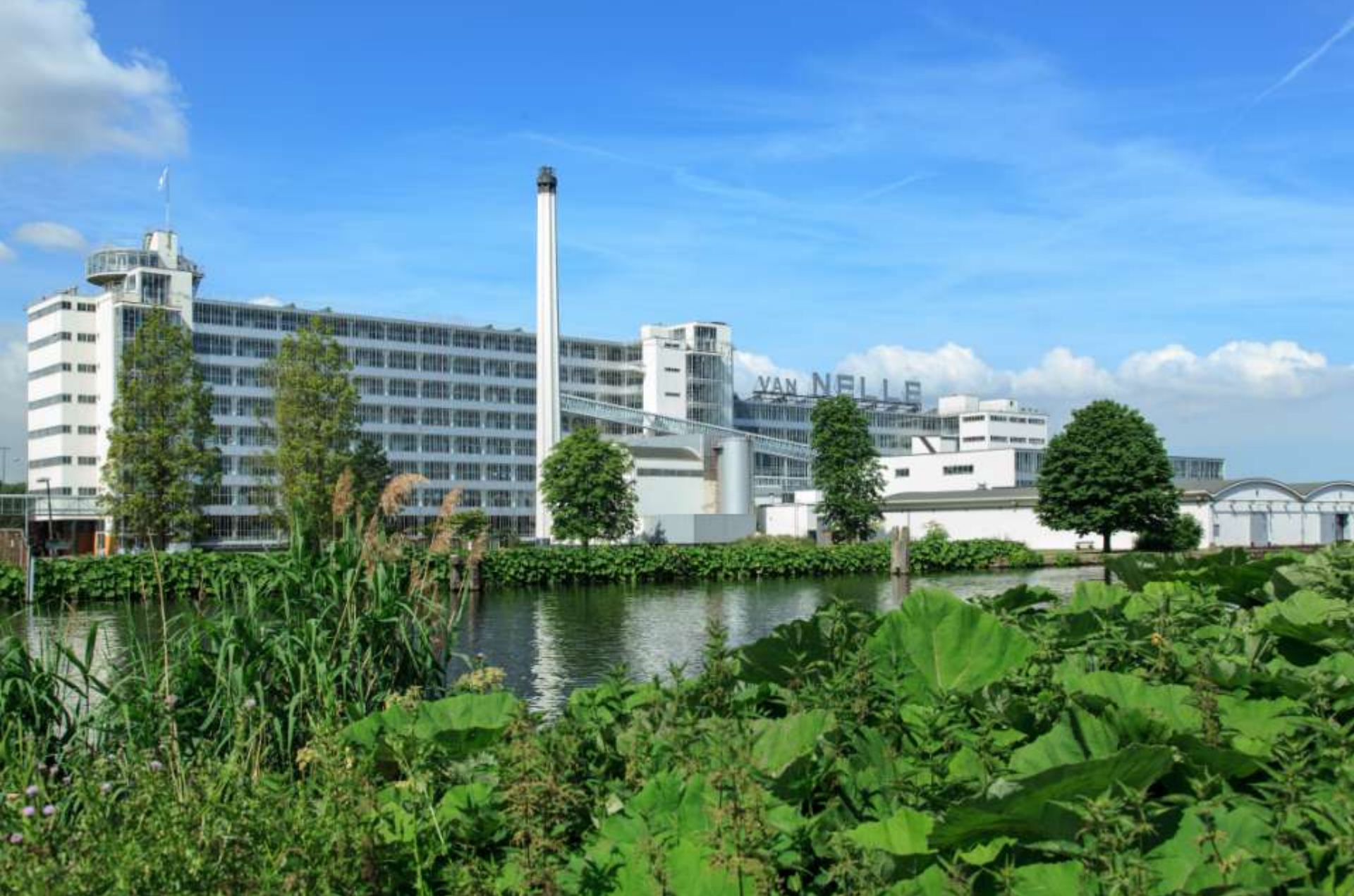
Van Nellefabriek / Van Nelle Factory (2014)
